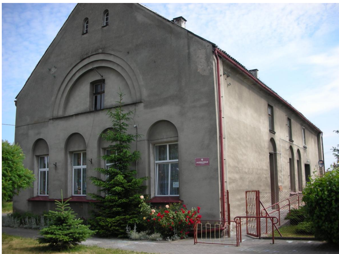
Fot. Przedszkole w Bukowcu
