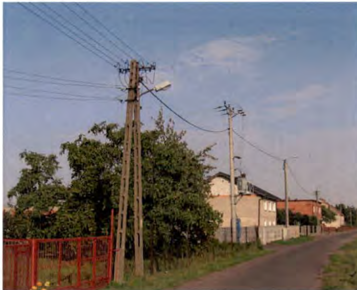
Fot. 5. Linie dystrybucyjne nn-0,4 kV (przykłady)
