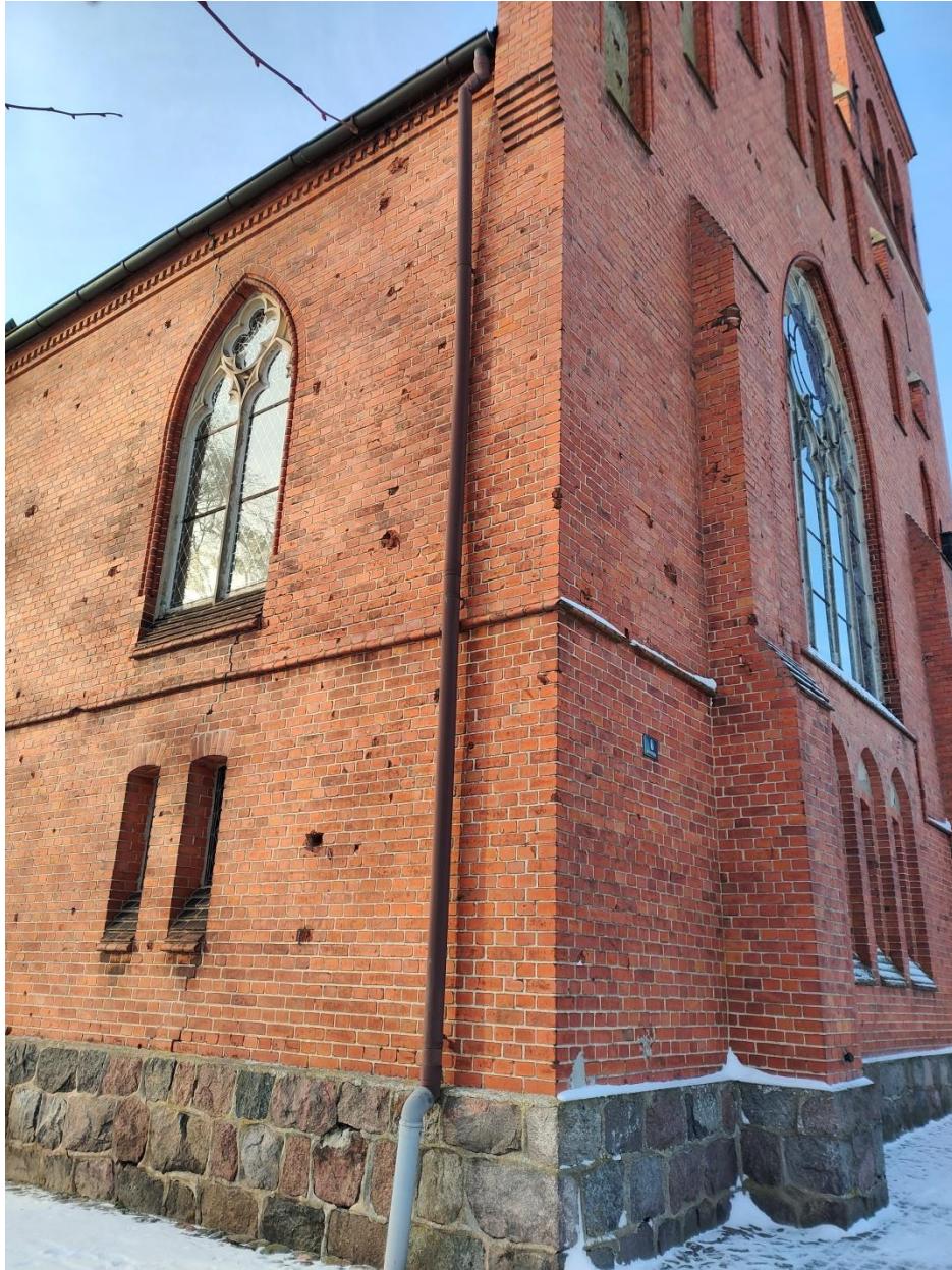
Widok istniejącej rury spustowej oraz rynny
