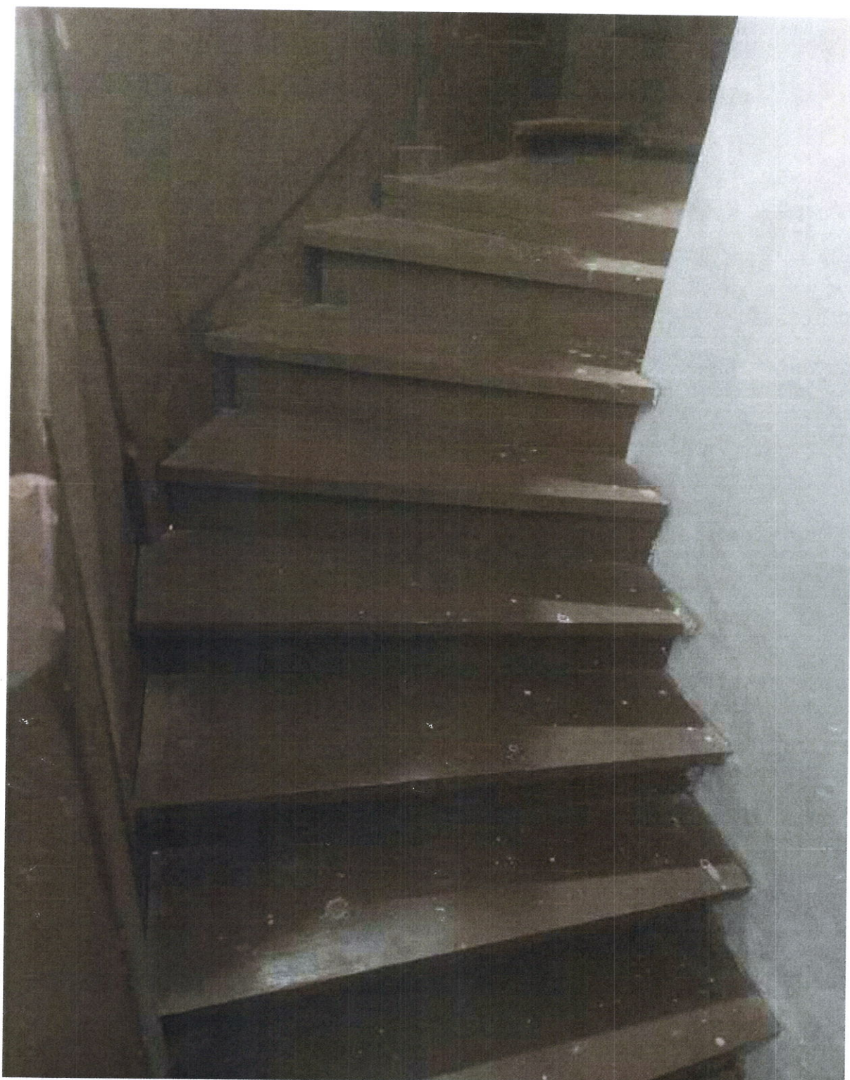
Schody ambony widok od góry
